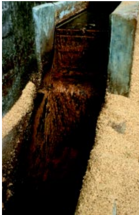
Abb. 1. Abwasserkanal, der sowohl das Abwasser aus der Separation der Kaffeebohnen von der Schale als auch Fermentationsabwasser erhält. Ein mehrere Zentimeter dicker Biofilm, der Hefen und Bakterien enthält, ist zu erkennen.
