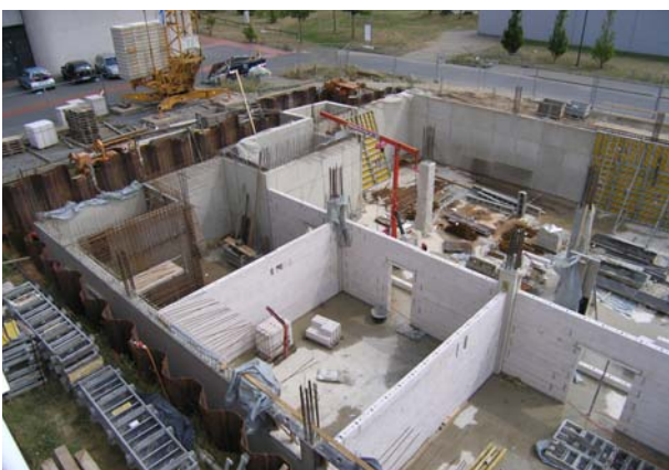
Das neue Maushaus auf dem HZI-Campus: Während der Aushebungsarbeiten (oben); Konstruktion des Kellergeschosses (unten) Fotos: HZI, Müller
