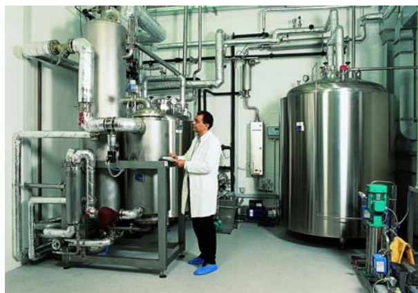
Dr. Neophytos Papamichael kontrolliert das Wasseraufbereitungssystem der GMP-II-Einheit am HZI. Foto: HZI, Bierstedt
