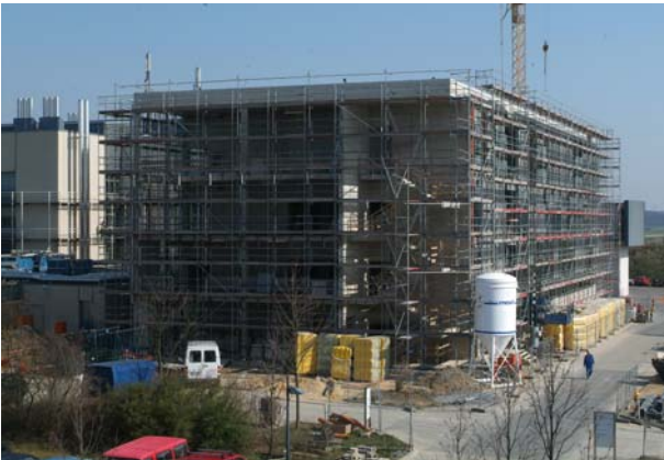
27. März 2007: Der Rohbau des neuen Maushauses ist fertig.
